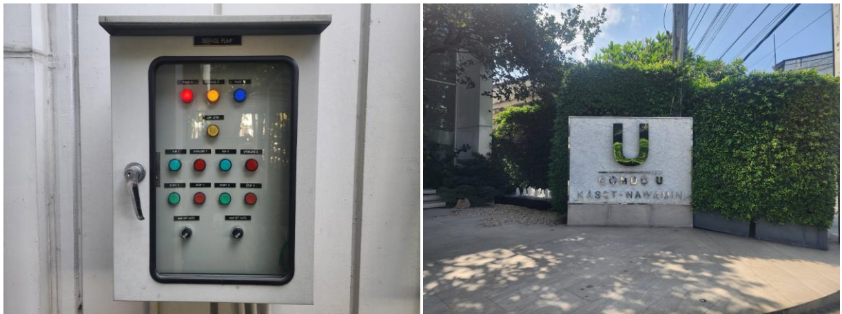
รูปที่ 2-12 ตู้ควบคุมระบบบำบัดน้ำเสีย
